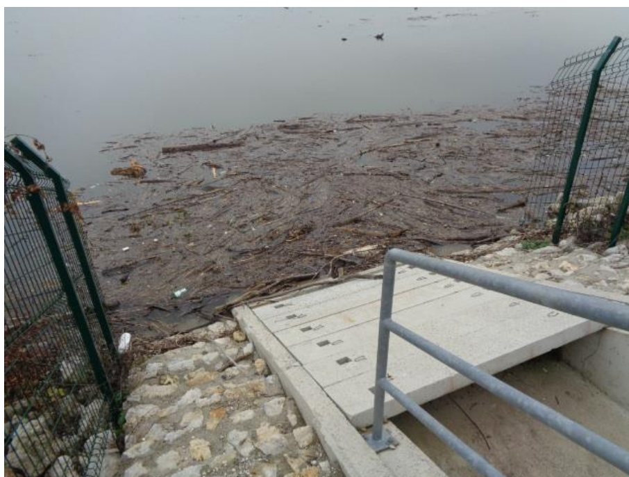
Slika 101. Kopičenje plavja pred vtočnim objektom v PvZO.
