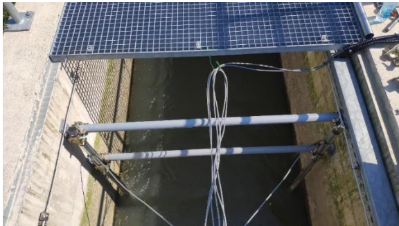
Slika 34. Video nadzorni sistem na vtočnem kanalu ribje steze
